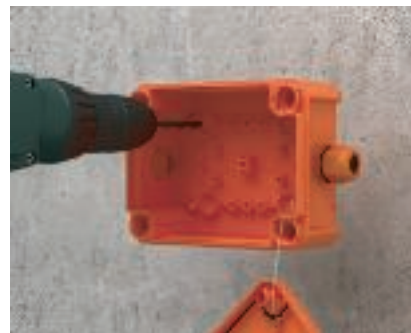
Wykonać otwory mocujące Wywiercić otwory w dnie do mocowania ściennego.
