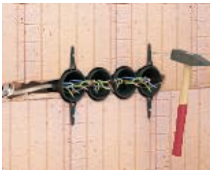
Montaż puszek osprzętowych obejmami z gwoździem Puszki osprzętowe podtynkowe z listwą gwoździową można mocować w murze za pomocą gwoździ stalowych. Listwa gwoździowa zapobiega zbyt głębokiemu umieszczeniu puszek w otworze montażowym
