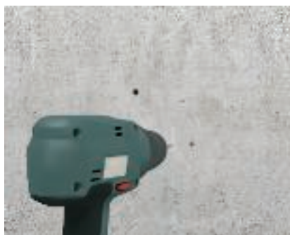
Wywiercić otwory mocujące Średnica wywierconego otworu 5 mm, gł. 60 mm. Dobrze wyczyścić otwory!
