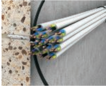
Zamocować przewody Przewody lub kable, które mają zostać zainstalowane należy połączyć za pomocą opasek kablowych.
