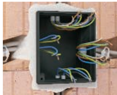
Instalacja rozdzielnic Za pomocą skrzynek rozgałęźnych podtynkowych można wykonać rozgałęzienia w ścianie.
