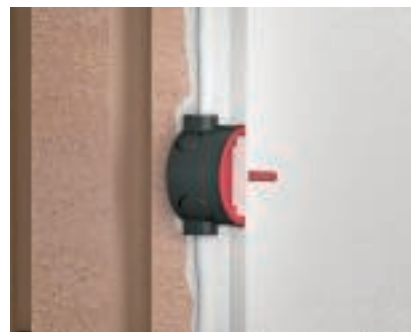
Pokrywa sygnalizacyjna Pokrywy sygnalizacyjne przed ułożeniem tynku są nakładane nauszki osprzętowe i instalacyjne. Zapobiegają one zabrudzeniu wnętrza puszek i ułatwiają ponowne ich znalezienie po zatynkowaniu.
