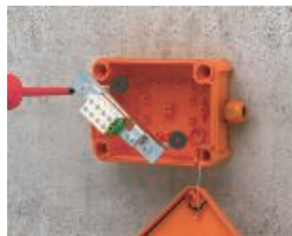
Montaż jednostki przyłączeniowej Kotwę wkręcaną z uszczelkami zamocować za pomocą kabląka a dno rozgałęźnej skrzynki kablowej bezpośrednio na podłożu.
