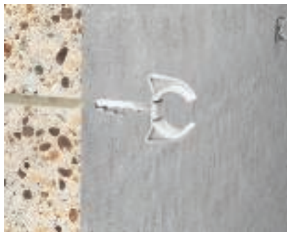
Zastosowanie uchwyty Snap Zaznaczyć trasę instalacji i wykonać otwory montażowe.
