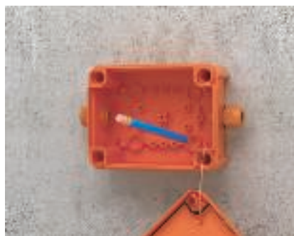
Przygotowanie do montażu Zaznaczenie otworów na potrzeby późniejszego montażu.
