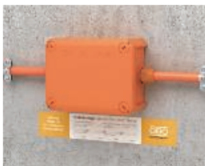
Oznaczenie Umieścić tabliczkę z danymi na temat wykonanej instalacji wg DIN 4102 część 12.
