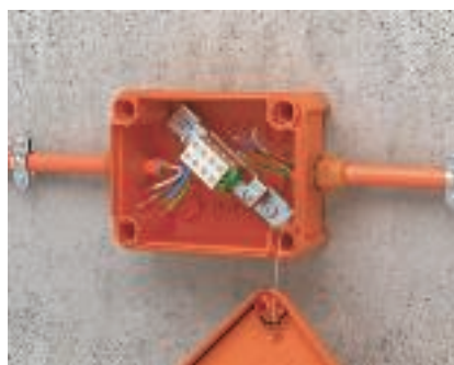
Wprowadzanie przewodu Usunąć izolację z końcówek kabli i wsunąć przez dławik kablowy do rozgałęźnej skrzynki kablowej.
