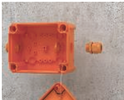
Montaż dławików kablowych Mocowanie dławików kablowych V-Tec za pomocą przeciwnkrętek.
